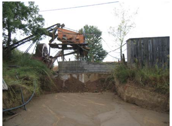
Figura 19 – Extracção de inertes a 1 km jusante de D1.
